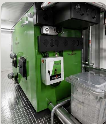
Kotłownia kontenerowa HSK-RA 450 kW
